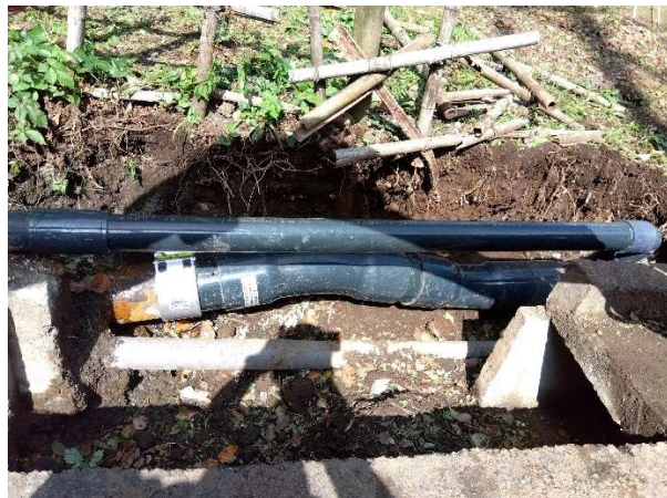
破損した温泉管（拡大）
