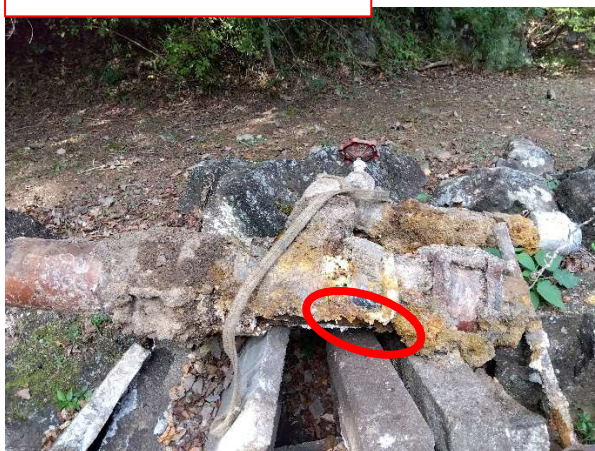
破損した温泉管（鉄管）
